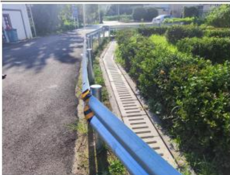
主体工程区排水措施
