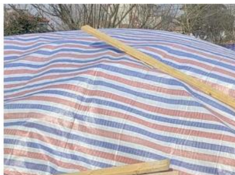
材料堆放临时苫盖
