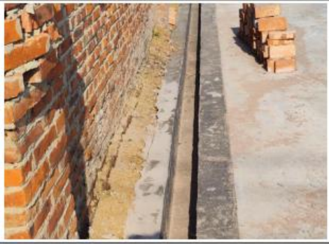
施工临时设施区临时排水沟
