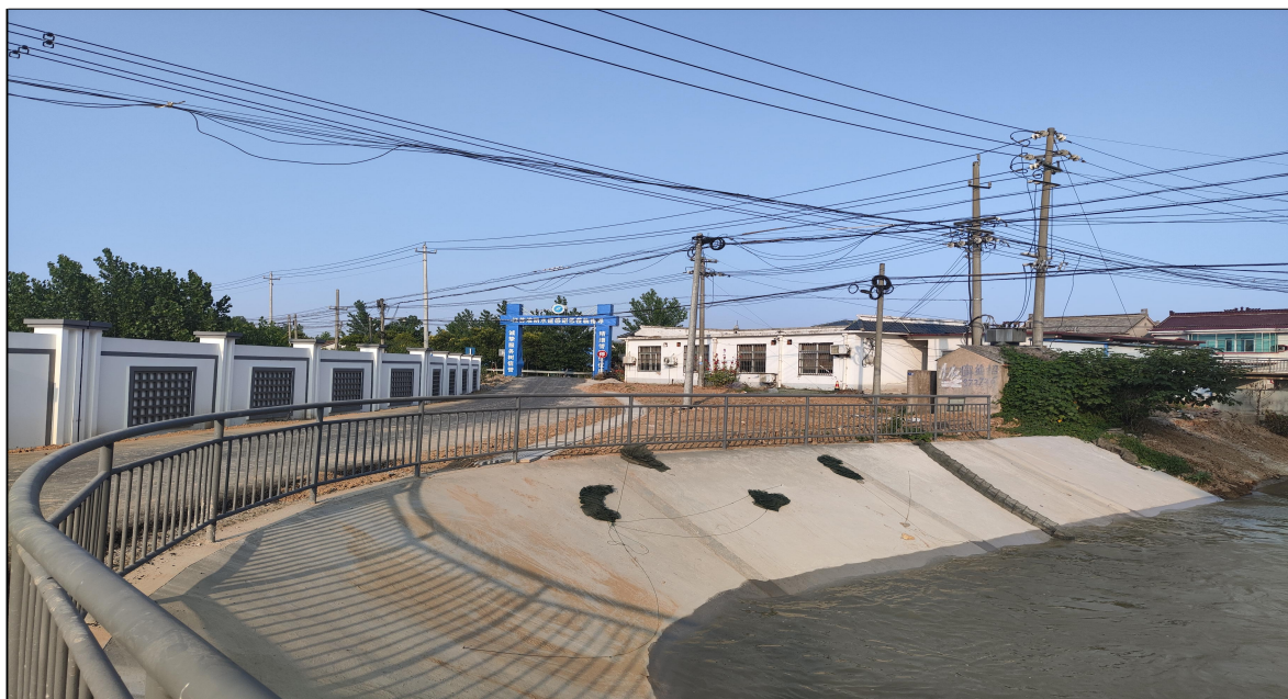
图 4-1 现场实际建设图
