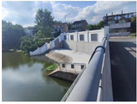
主体工程区硬化
